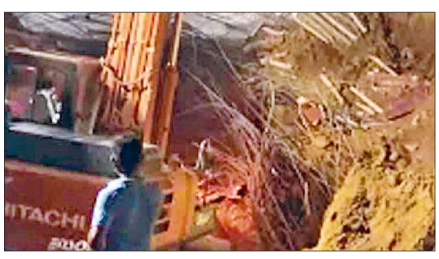
गुरुग्राम। सिधरावली के पास सिग्नेचर ग्लोबल कंपनी की कंस्ट्रक्शन साइट पर मिट्टी दबने से दबे मजदूरों को जैसीसी बें निकालने का प्रयास करते बचावकर्मी। फोटो: हरिभूमि
